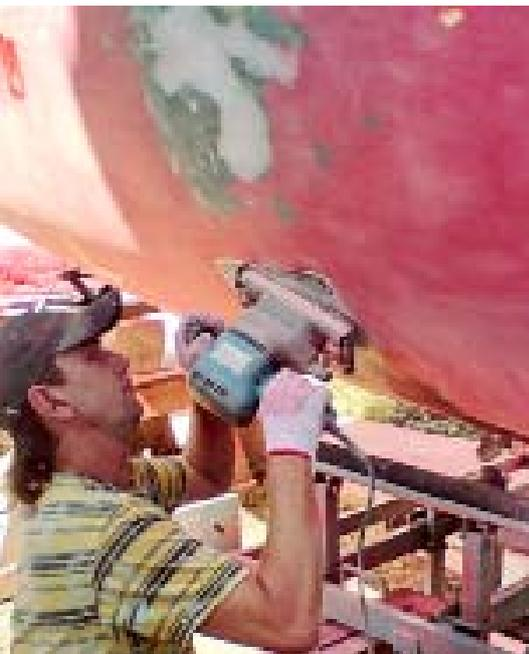
Выравнивание поверхности латки плоскошлифовальной машиной
